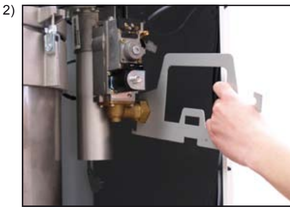
Svitare il raccordo a vite attacco alla valvola gas
