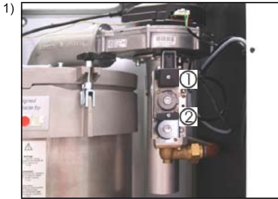
Stecker ①② abziehen (vorher Kreuzschlitzschrauben lösen)
