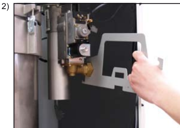
Desenroscar racor de la conexión de gas de la válvula multigás
