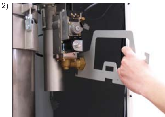
Verschraubung Gasanschluss am Gaskombiventil lösen
