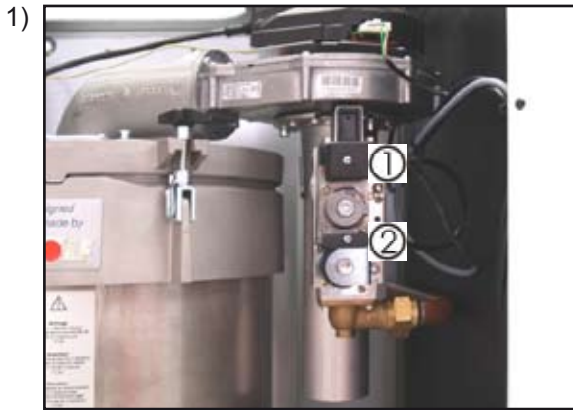
Desenchufar el conector ①② (después de desenroscar los tornillos de estrella)
