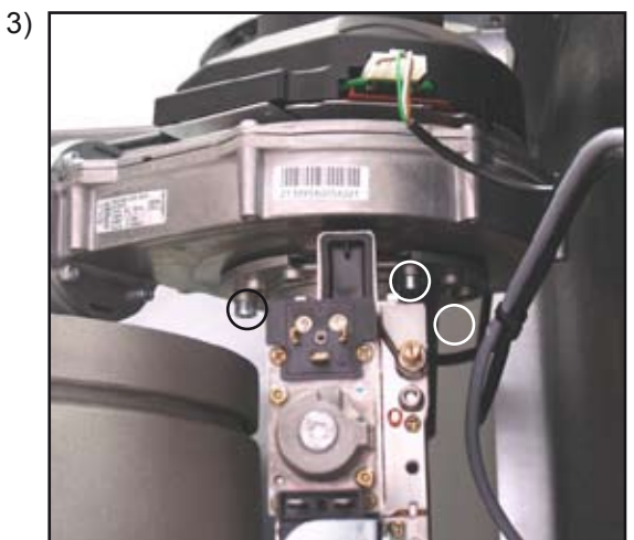
Svitare la camera di miscelazione dal ventilatore (3 viti a testa esagonale interna 5 mm), eventualmente estrarre il tubo di aspirazione aria
